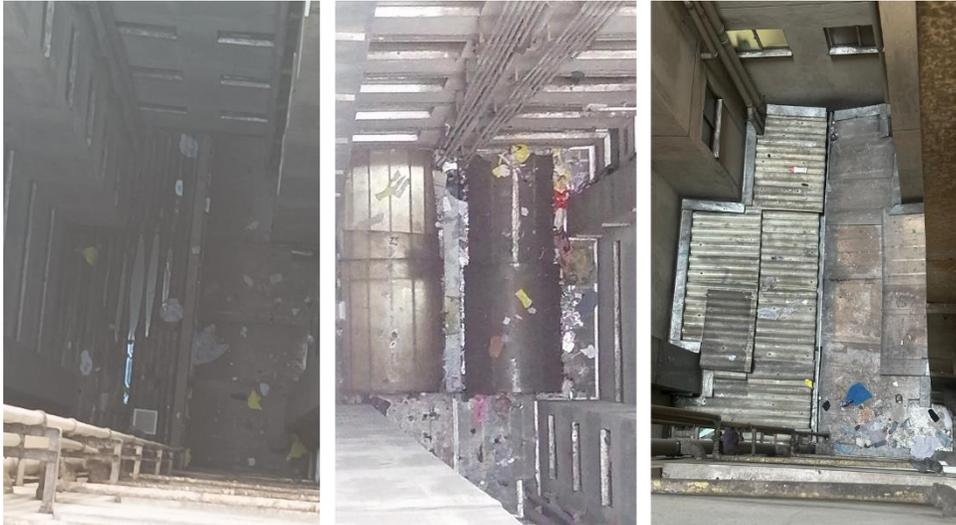
*Ilustración 1 Policarbonatos ubicados en fosos de iluminación.*
