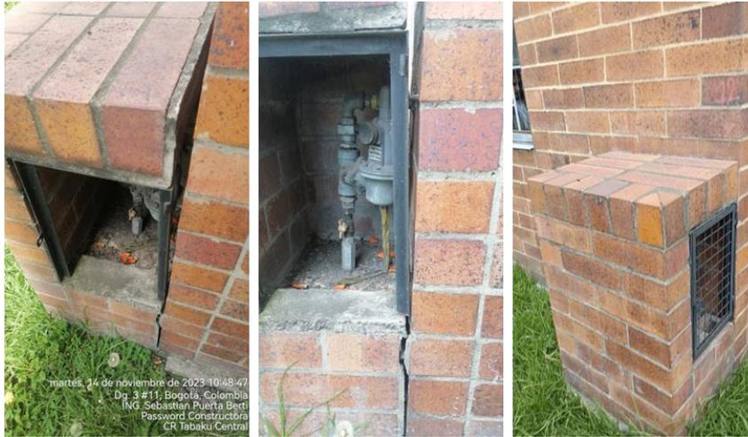
*Ilustración 6 Comparativa de tapas de cajas existentes.*
