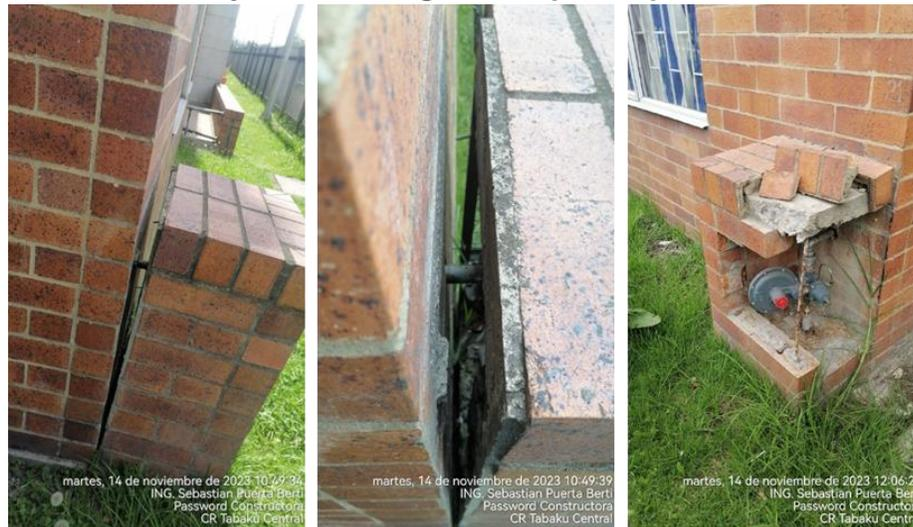
*Ilustración 17 caja de red de gas destruida en el primer piso*
