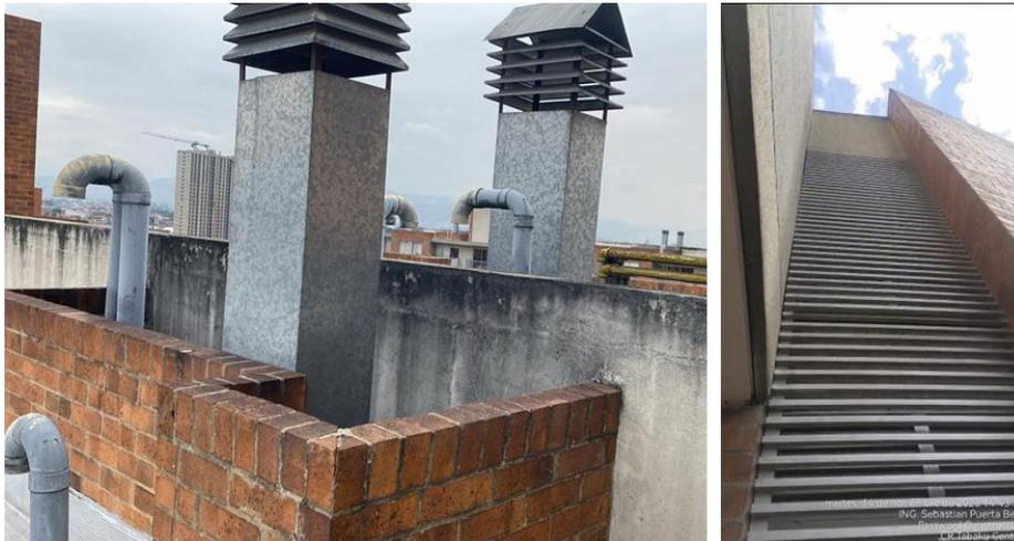
*Ilustración 5 Conductos ubicados en vacíos.*
