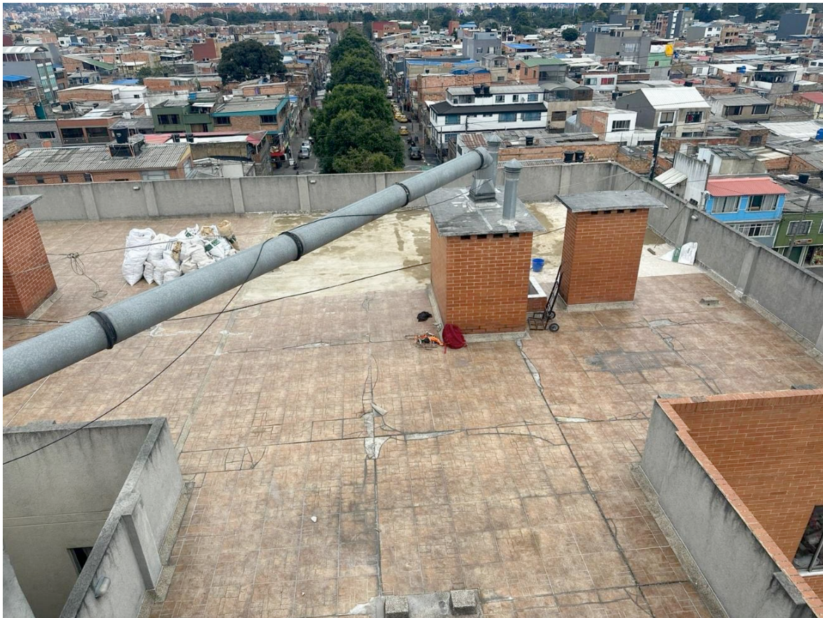
Imagen Condición General Terraza Torre 2.
