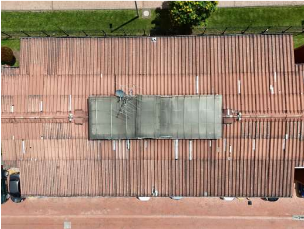
Imagen de referencia general de cubierta
