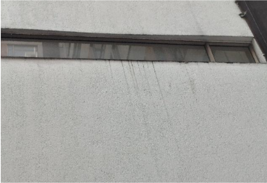
Imagen de fachadas en graniplast manchado.
